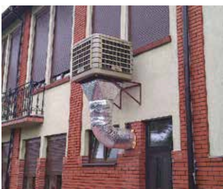
Zajazd „SKORPION” Łódź Wykonanie instalacji „MODIUM ŁÓDŹ”
