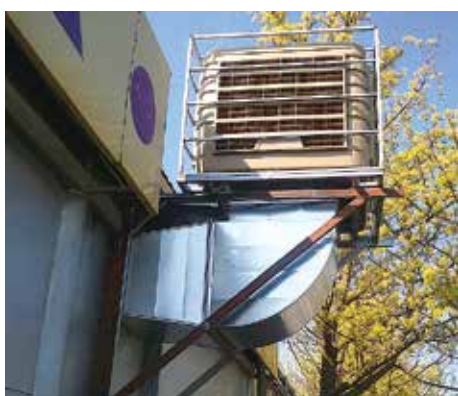
Serwis samochodowy „SZANIEC” Gorzów Wlkp.
