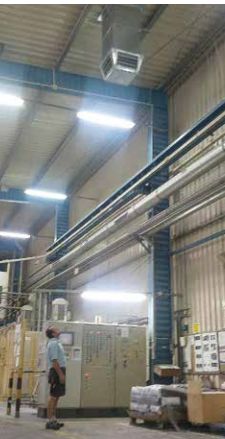
Hala przemysłowa „SOLVAY” Gorzów Wlkp.
