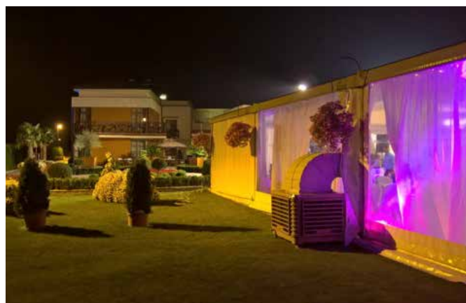
Chłodzenie namiotu cateringowego realizacja „MODIUM”
